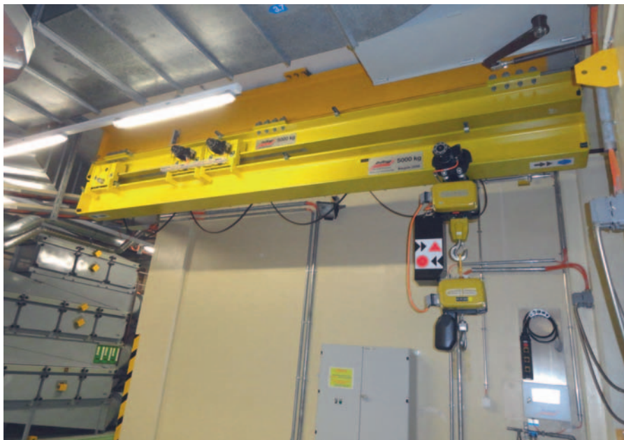
Die von vier Motoren, mit Frequenzumrichter, verschiebbare Kranbahn befindet sich in ihrer inneren Endposition und die Panzertüre ist geschlossen. Der ursprüngliche Giebelkranträger sorgt für eine feste Deckenverankerung. (Bilder: GIS)
