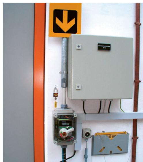
5 Anlageschalter (Kranschalter), der in der ausgeschalteten Stellung mit einem Vorhängeschloss gegen Einschalten gesichert werden kann.
